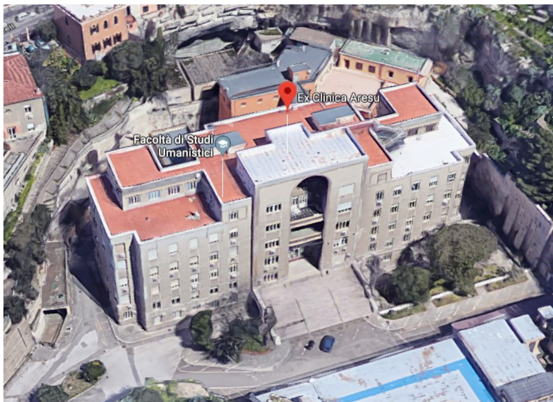
Foto n. 3 –Edificio della Ex Clinica Aresu-Vista dall’alto
